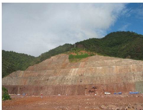
图8 溢洪道消力塘左侧边坡 755~740 m 高程开挖完成后实景图
